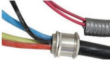
Fig 3.8. Conduit Wiring
