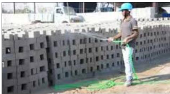
Fig 3.1.curing techniques
