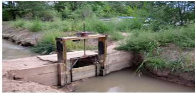
Fig. 1.10: Canal check gates
