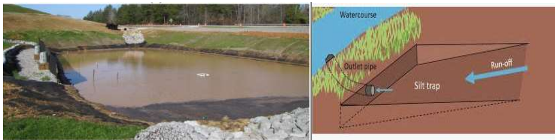
Fig. 7.1. Silt trap
