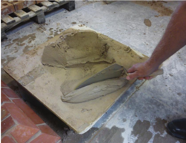
Fig. 108 Rolling mortar.
